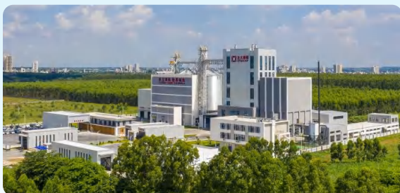
县域经济基金 2025 年 12 月 16 日完成对正大遂溪项目 2 亿元投资
