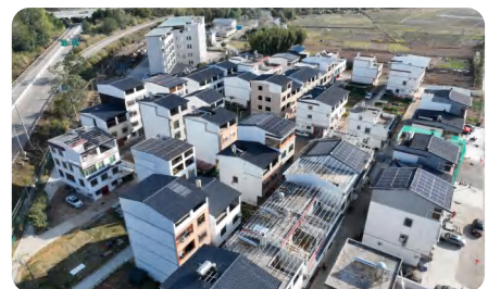
河源市东源县曲滩村“风貌提升+光伏”建设项目
