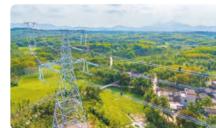
南方电网 - 海南 500 千伏主网架工程项目
