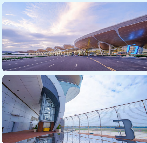
白云机场 T3 航站楼
