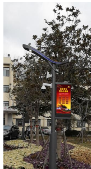
山东青岛智慧园区项目
